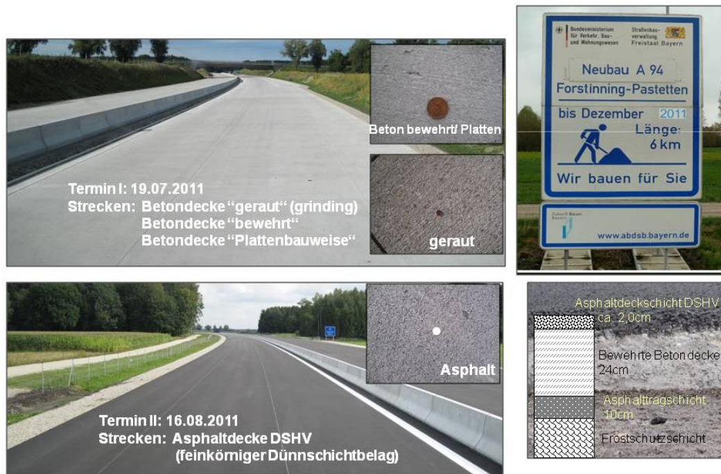
Abbildung 3.10: Autobahneubaustrecke bei "Forstinning"
