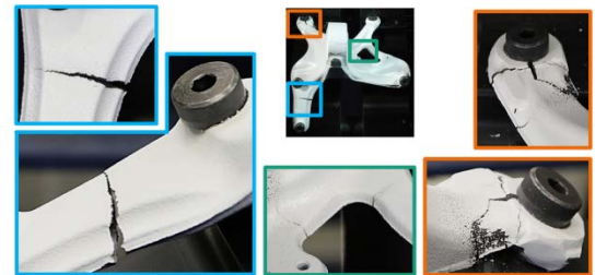
c) Rissverlauf in der dynamisch belasteten Konsole
