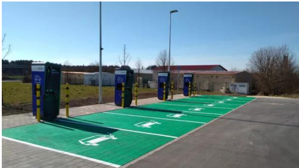
Abbildung 17 Schnellladestationen können heute schon Leistungen von über 300kW übertragen, sind hinsichtlich der Stellplätze in der Regel jedoch nur für Pkw ausgelegt. 57
